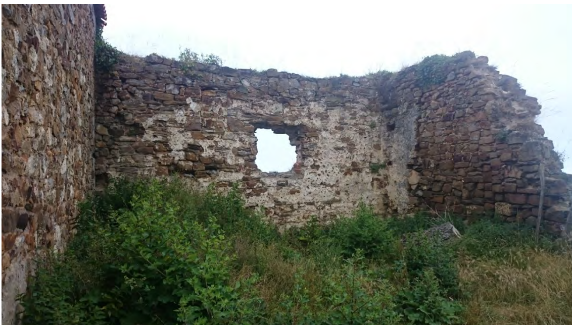
Vano existente en muro a consolidar
