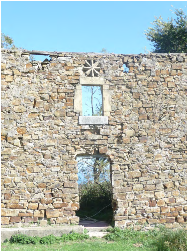
Muro existente del caserío
