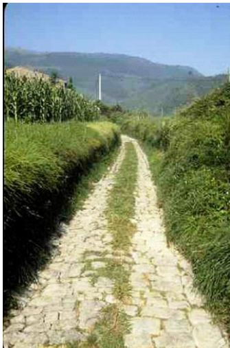
Calzada de Astigarribia, Mutriku – Camino de Santiago (Fuente: Diputación Foral de Gipuzkoa)
