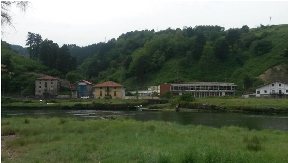
Fachada al río de Arzabal (Fuente: Debegesa)
