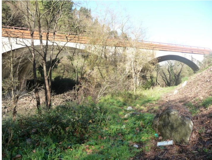
Puente de la carretera N-634 sobre el río Deba
