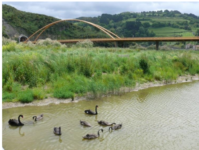
Puente de la carretera GI-638 sobre el río Deba desde el meandro con el barrio de Artzabal en la margen derecha
