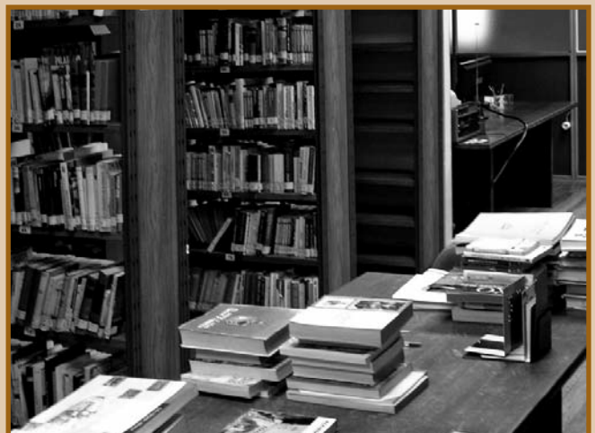
Estado actual de la sala dedicada a la biblioteca.
